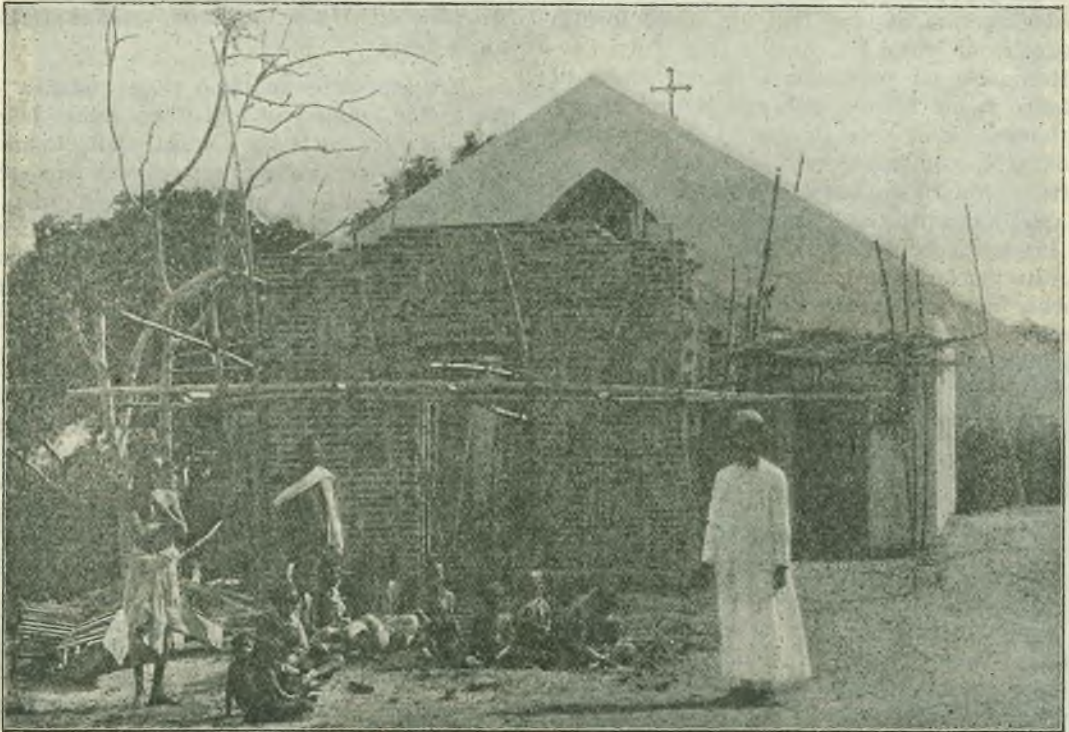
INDIA — LA NUOVA CAPPELLA IN COSTRUZIONE NEI DINTORNI DI TANJORE.
